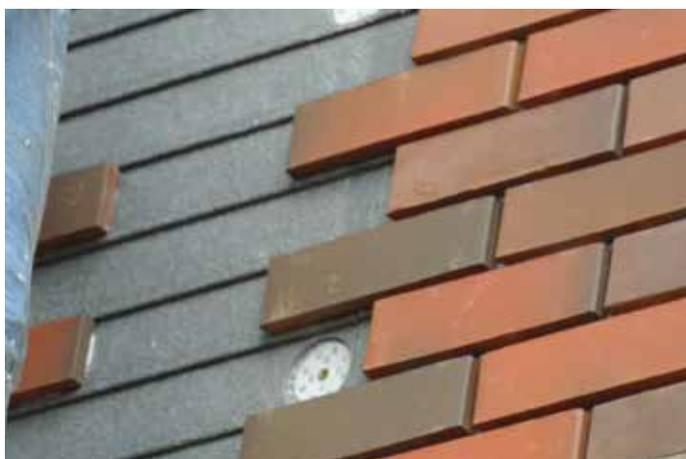
Para uma segurança adicional são utilizadas 5 fixações mecânicas com cavilha em aço (TermoFace.Fix) por placa de isolamento (aproximadamente 0,6 m<sup>2</sup>).
